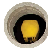
① Clapet vanne
